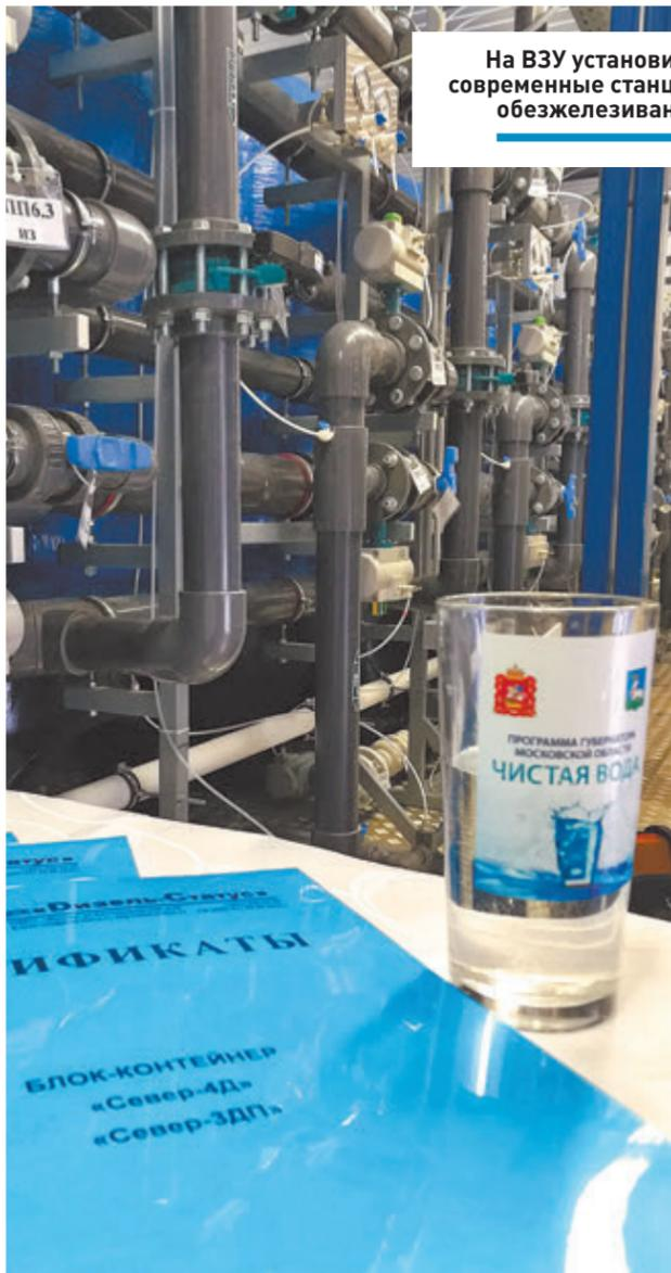
На ВЗУ установили современные станции обезжелезивания
